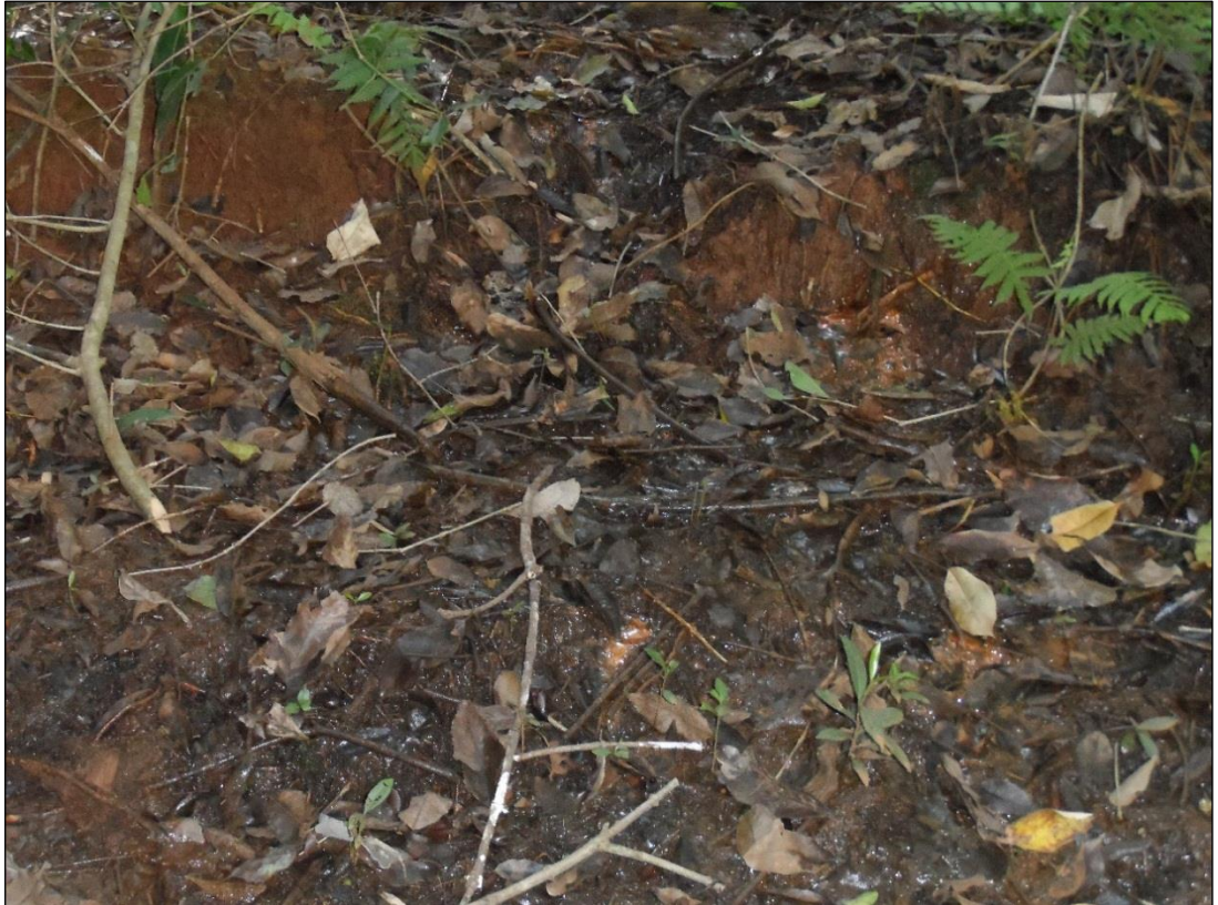
Vista da Infiltração no Pé do Talude de Jusante
