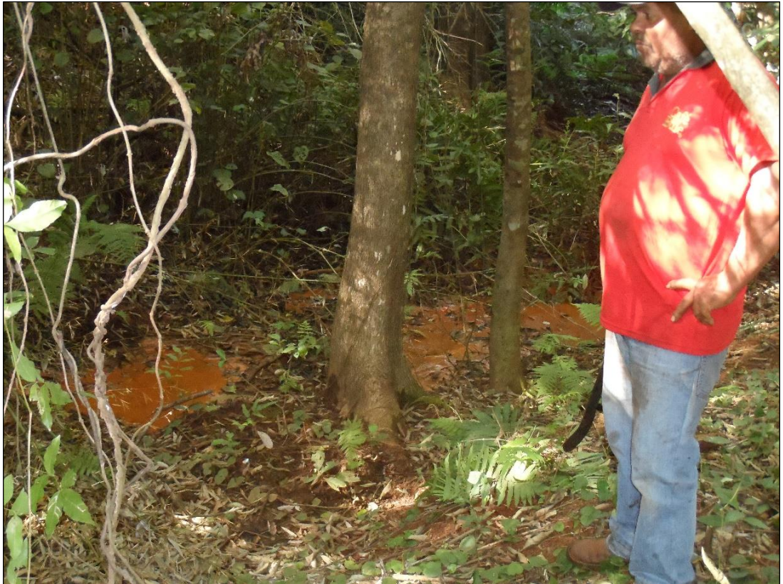
Vista da Drenagem à Jusante do Pé do Talude da Barragem
