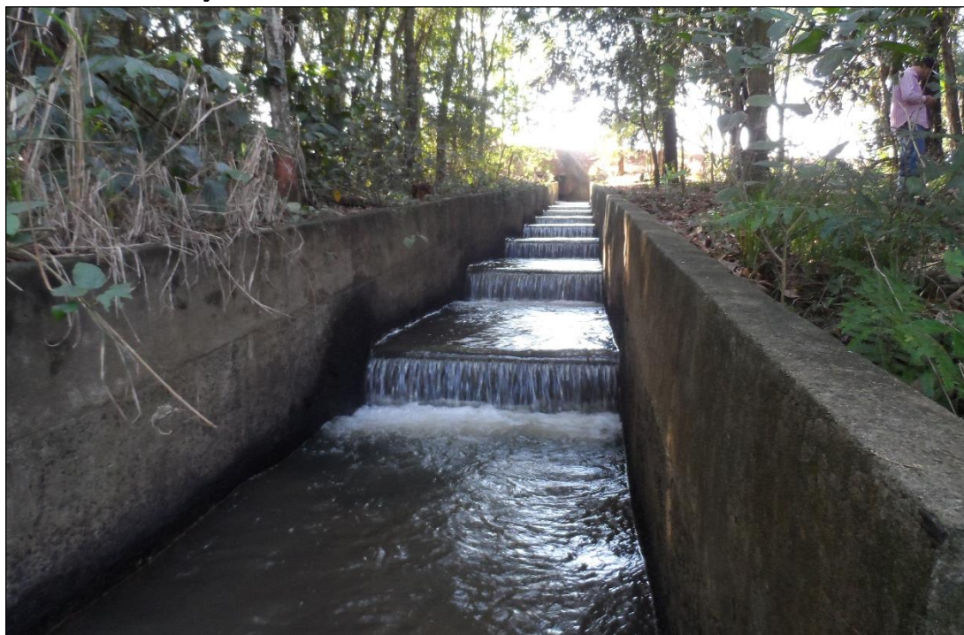
Canal de Restituição do Vertedouro
