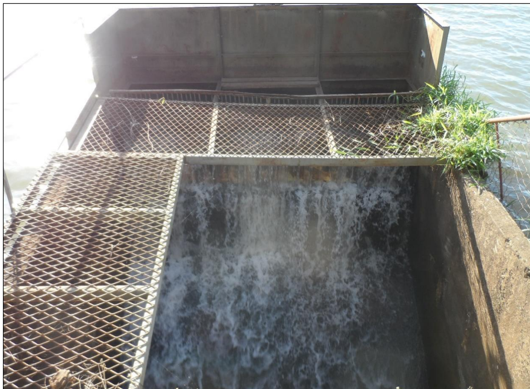
Detalhe da Estrutura do Vertedouro – Grades e Telas instaladas
