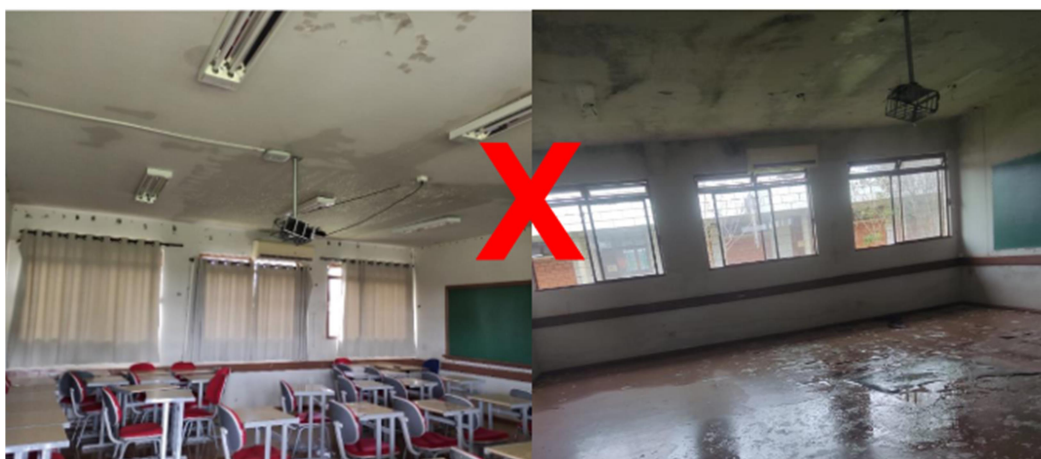
Figura 28: Evolução da degradação causada pelas intempéries nas salas de aula. A imagem a esquerda retrata a situação da sala em (24-10-2021). A imagem a direita esquerda retrata a situação da sala em (27-09-2022). Fonte: O Autor
