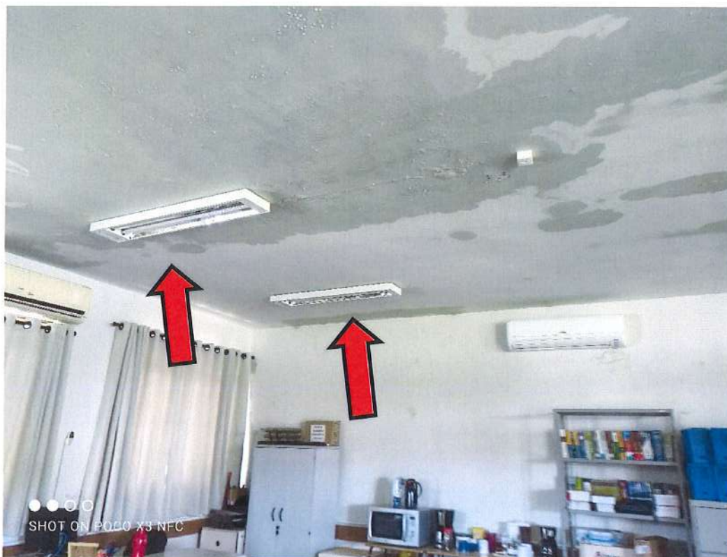
Figura 02: Luminárias das salas do Bloco F apresentam umidade devido a ação do vendaval. (24/10/2021). Fonte: Diretoria de Planejamento Físico – Unioeste
