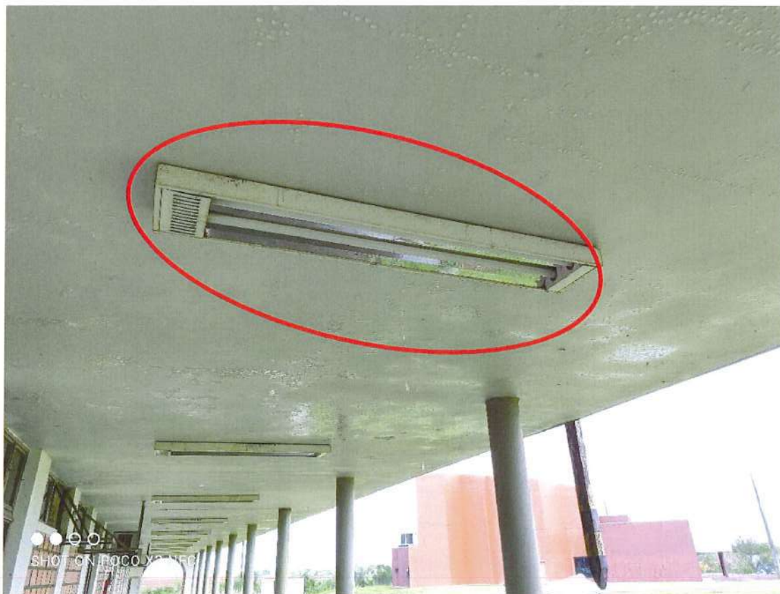
Figura 01: Luminárias do corredor do Bloco F apresentam umidade devido a ação do vendaval. (24/10/2021). Fonte: Diretoria de Planejamento Físico – Unioeste
