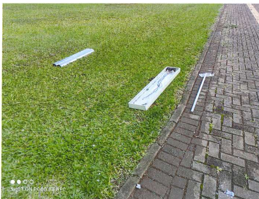
Figura 03: Luminária arrancada devido a ação do vendaval. (24/10/2021). Fonte: Diretoria de Planejamento Físico – Unioeste
