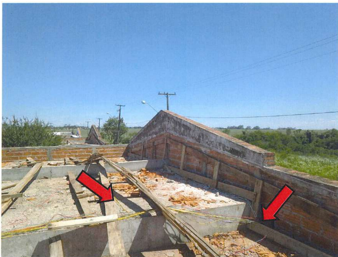
Figura 04: Cabos Elétricos arrancados pela ação do vento do vendaval. (21/11/2021). Fonte: Diretoria de Planejamento Físico – Unioeste
