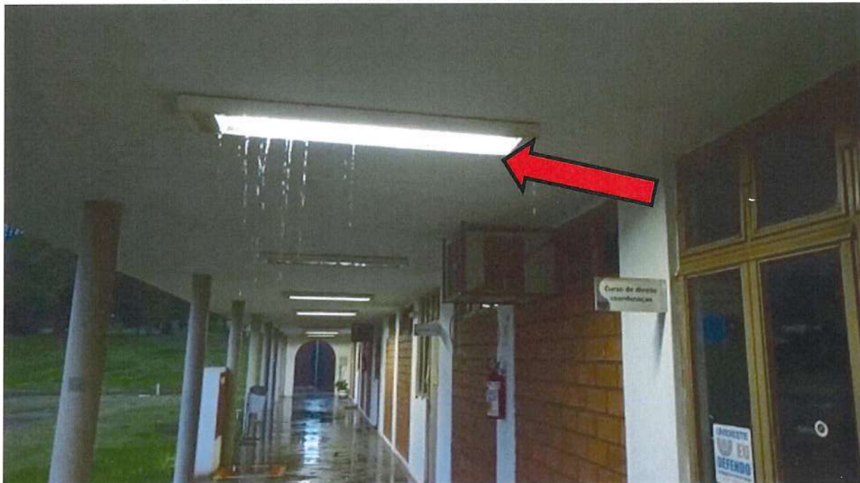
Figura 04: Luminárias escorrendo água. (23/10/2021). Fonte: Diretoria de Planejamento Físico – Unioeste
