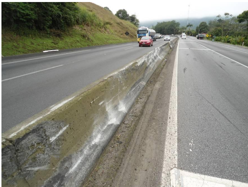
Imagem 71 – detalhe das marcas nas paredes e topo da mureta indicando a transposição de V1B , sentido Paranaguá.
