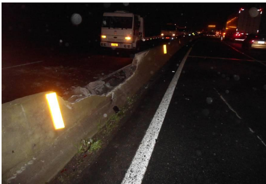
Imagem 68 – ruptura da mureta central no trecho inicial do acidente, sentido Paranaguá.
