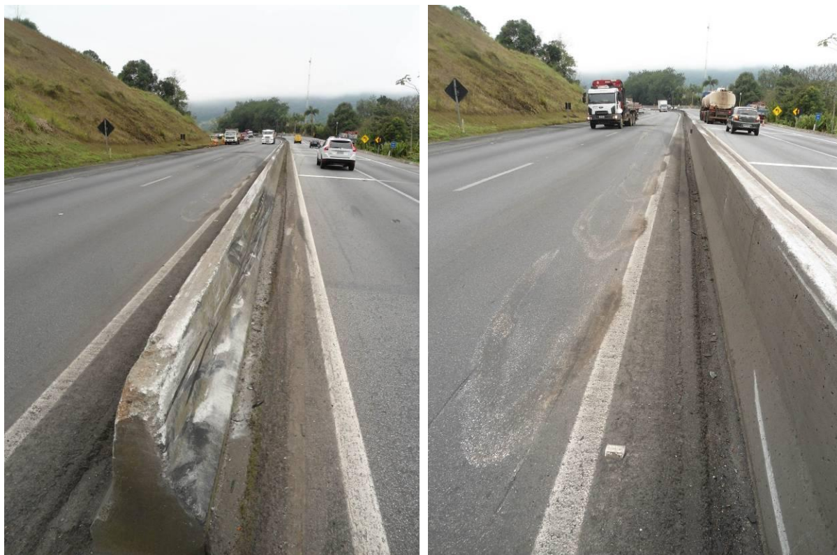
Imagem 73 e 74 – vista diurna do detalhe das marcas da transposição de V1B sobre a mureta central e no leito asfáltico.
