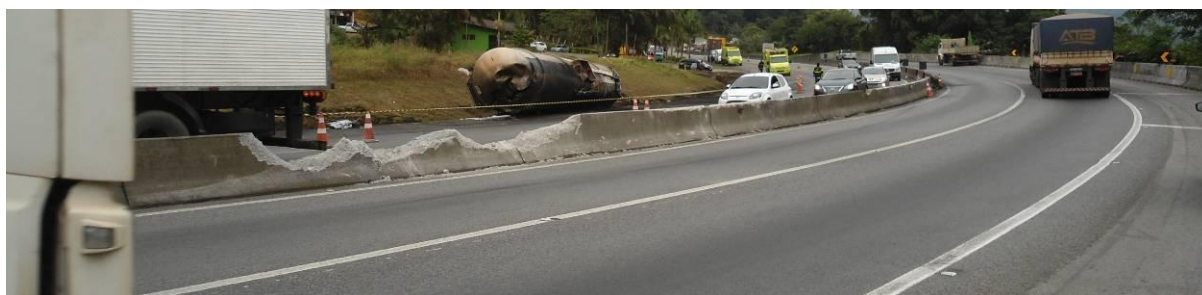
Imagem 77 – vista diurna da ruptura de aproximadamente 07 m de mureta por conta da escalada de V1A sobre referida barreira divisória.
