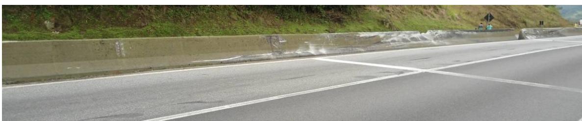
Imagem 69 – primeiras marcas da transposição de V1B sobre a mureta, sentido Paranaguá.
