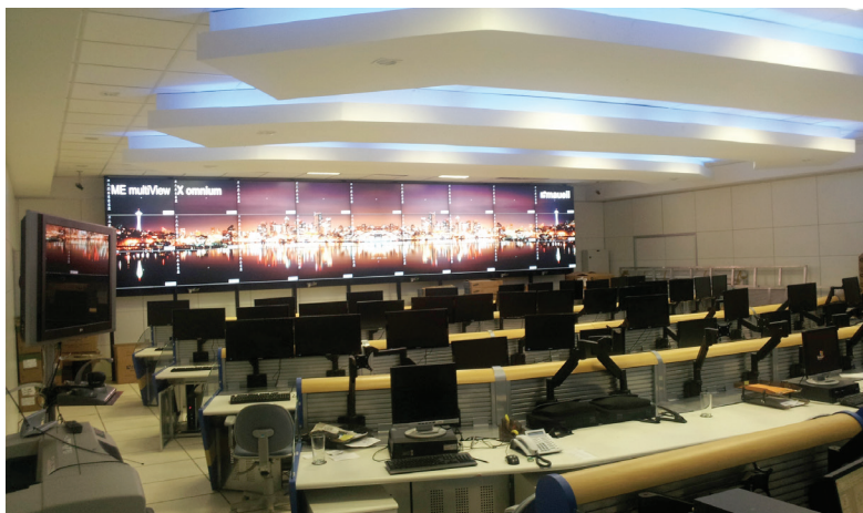
Figura 3: Sala de Monitoramento de Riscos e Desastres do Centro Nacional de Gerenciamento de Riscos e Desastres
