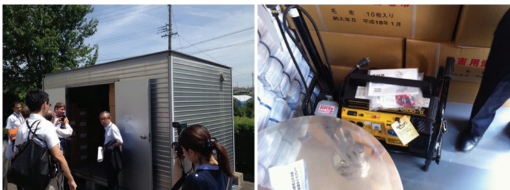
Figura 5: Fotos de contêiner com kit de Assistência Humanitária – Escola Fundamental Ishihamanishi – Município de Higashiura – Japão
