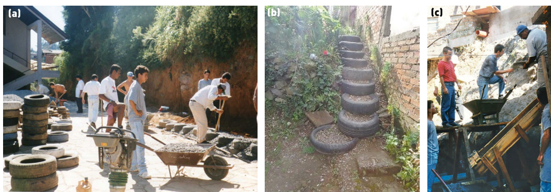
Figura 7.58. Imagens das aulas práticas mostrando: (a) a construção de “muro de pneus”, (b) “escadaria no terreno de um morador” e (c) “obra de contenção (gunitagem) para manter moradias em segurança”.
