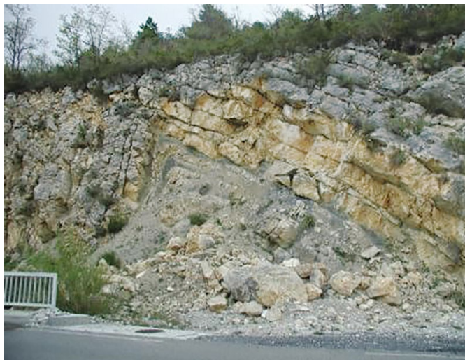
Figura 7.13. Imagem de quedas de blocos de rocha, causadas por descontinuidades da rocha. Fonte: IPT.
