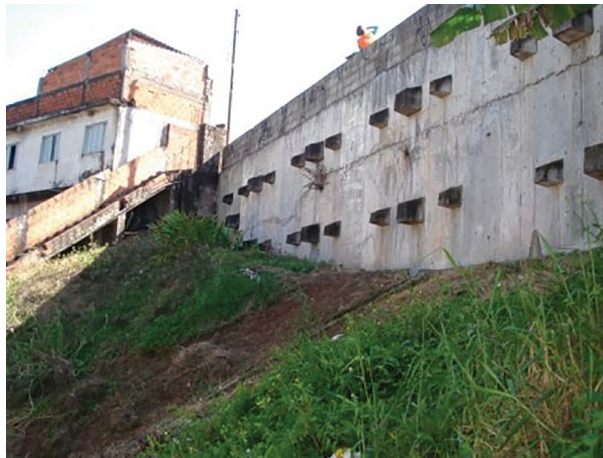
Figura 7.16. Imagem de obra de contenção realizada com uso de atirantamentos. Fonte: IPT.
