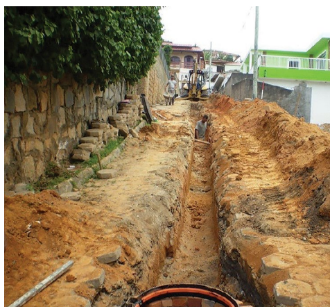
Figura 7.26. Imagem de uma construção de rede coletora de esgoto no maciço do Morro da Cruz, Florianópolis/SC. Fonte: Companhia Catarinense de Águas e Saneamento.
