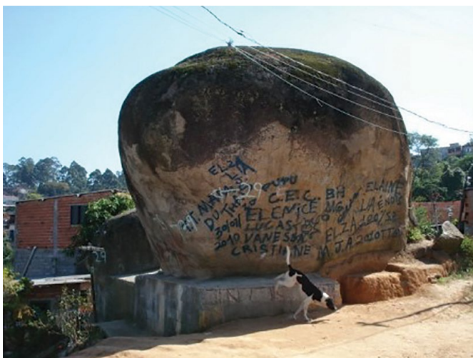
Figura 7.12. Imagem de uma obra de estabilização de um bloco de rocha com concreto na base. Fonte: IPT.
