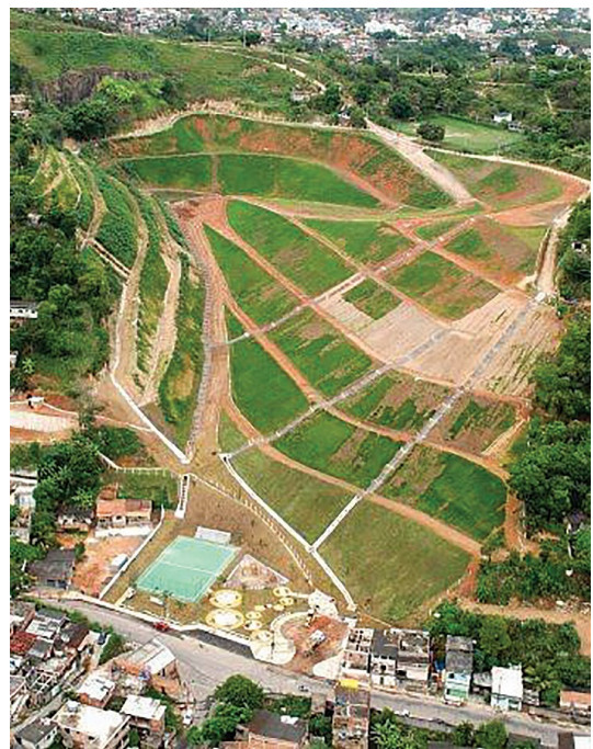
Figura 7.31. Imagem aérea das obras de reconstrução feitas após o escorregamento no morro do Bumba em Niterói/RJ com retaludamento, drenagem superficial e coleta de chorume. Fonte: O Globo.
