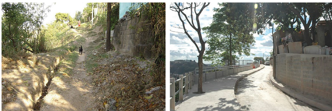
Figura 7.1. Imagens do Beco São Vicente, em Belo Horizonte/MG, antes e após a realização de obras de contenção de deslizamentos. Fonte: Prefeitura de Belo Horizonte.
