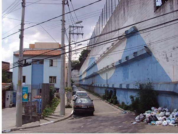
Figura 7.15. Imagem de obra contenção realizada com uso de atirantamentos. Fonte: IPT.
