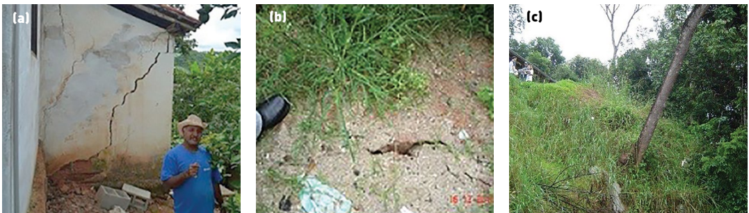
Figura 4.1: Feições de instabilidade: a) trincas em casas; b) degraus de abatimento no terreno; c) inclinação de postes, muros e árvores.
