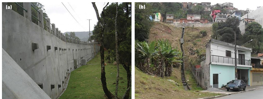
Figura 7.2. Medidas estruturais em encostas: (a) Cortinas atirantadas na Rodovia RJ 142, Nova Friburgo-RJ; (b) Escadaria hidráulica. Fonte: (a) Sope Engenharia e (b) IPT.
