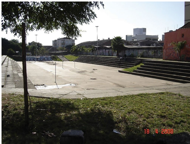
Figura 7.22. Bacia de detenção utilizada também para fins esportivos em Porto Alegre/RS.
