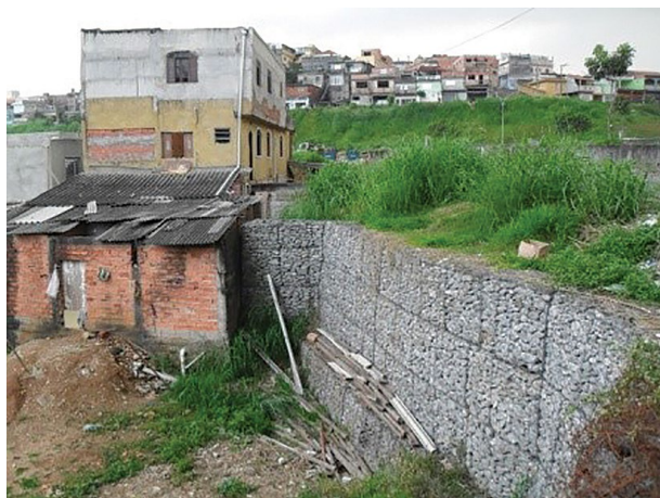
Figura 7.8. Imagem de um muro de gabião. Fonte: IPT.
