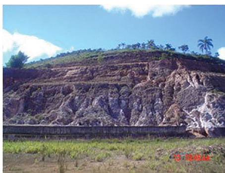
Figura 7.18. Imagem de um talude adjacente a uma ferrovia antes e após, respectivamente, ser revestido com biomassa, Brasil.
