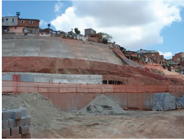
Figura 7.19. Imagem de uma obra de revestimento artificial para proteção de um talude. Fonte: IPT.
