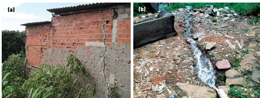
Figura 6.4. Evidências de Risco – (a) Casa com rachadura e (b) Esgoto não canalizado. Fonte: IPT.
