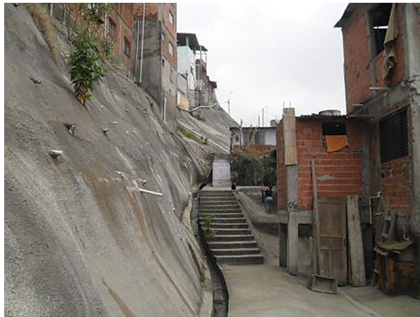
Figura 7.20. Imagem de uma obra de contenção e estabilidade de encosta complementadas com valetas de drenagem e drenos de faceamento (tubos). Fonte: IPT.
