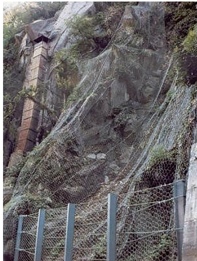
Figura 7.14. Imagem de uma queda de blocos de rocha com aplicação de medidas estruturais (utilização de tela de proteção contra quedas de blocos). Fonte: IPT.
