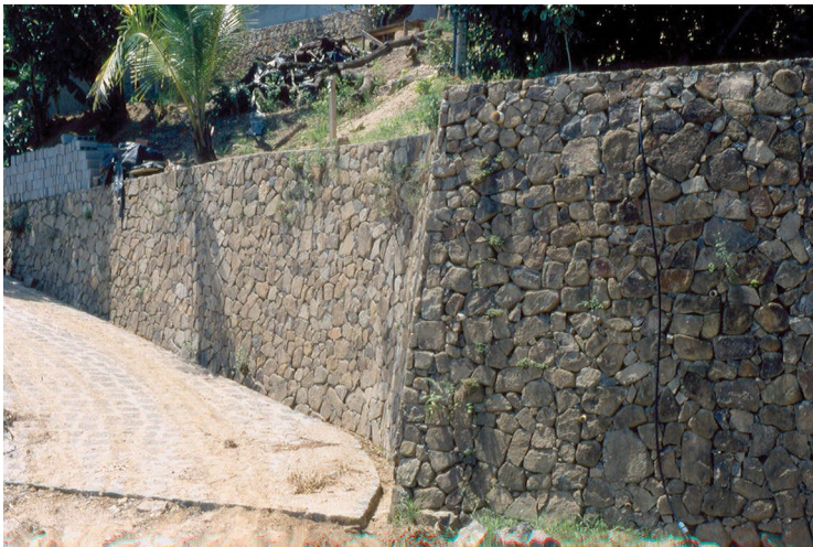
Figura 7.6. Imagem de um muro de pedra seca. Fonte: IPT.
