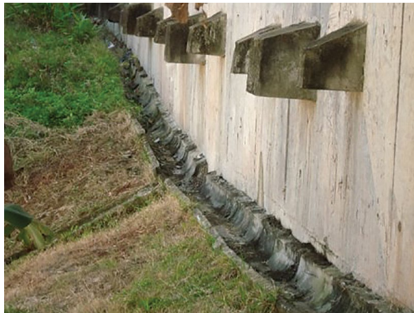
Figura 7.21. Imagem de uma obra de contenção e estabilidade de encosta com utilização de estruturas de drenagem. Fonte: IPT.
