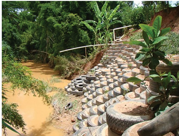
Figura 7.10. Imagem de um muro de pneus. Fonte: IPT.
