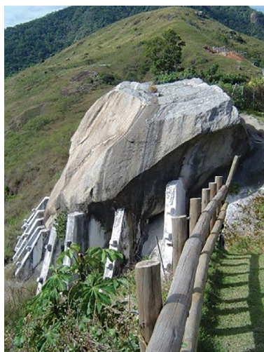
Figura 7.11. Imagem de uma obra de estabilização de um bloco de rocha com uso de suportes de concreto e chumbadores. Fonte: IPT
