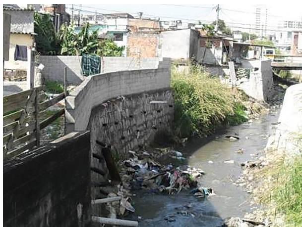
Figura 7.7. Imagem de um muro de pedra argamassada. Fonte: IPT.
