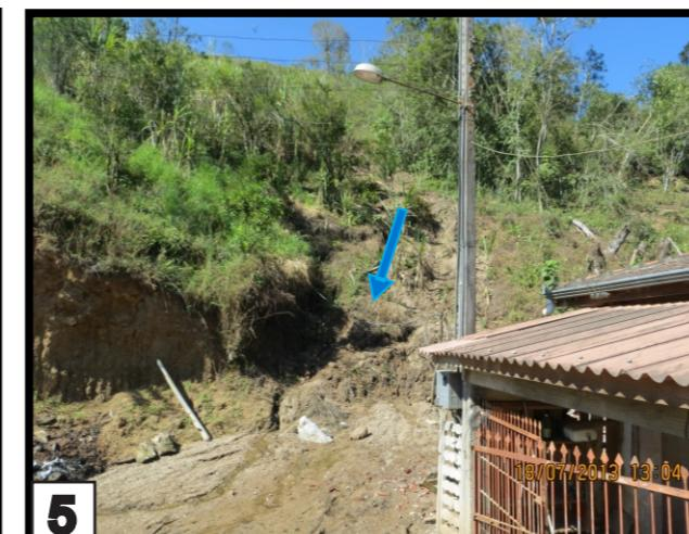
**Descrição:** Casas construídas a beira de encosta com aproximadamente 50 graus de inclinação, e 100m de altura, sem a vegetação nativa (Fotos 1 a 5). Esta encosta apresenta nascentes de água, cicatrizes de escorregamento, trincas, degraus e árvores inclinadas evidenciando o movimento de massa. Uma das casas do polígono foi parcialmente destruída devido a um deslizamento planar (Fotos 03,04 e 05). Foram observados matacões soltos e rolados junto ao material que deslizou no último evento.
