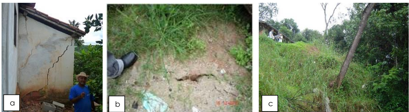
Figura 1: Feições de instabilidade: a) trincas em casas; b) degraus de abatimento no terreno; c) inclinação de postes, muros e árvores.
