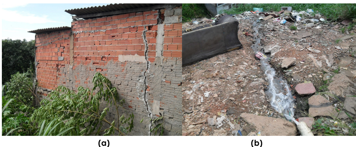
Figura 4. Evidências de Risco – (a) Casa com rachadura e (b) Esgoto Não canalizado. Fonte: IPT.
