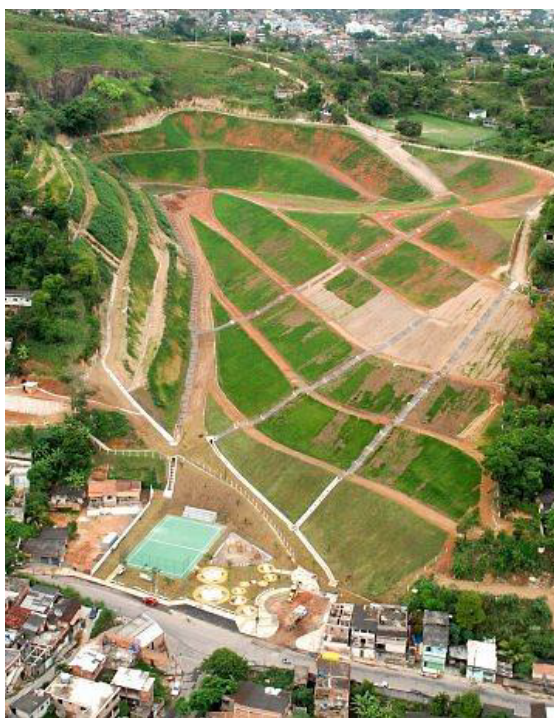
Figura 31. Imagem aérea das obras de reconstrução feitas após o escorregamento no morro do Bumba em Niterói/RJ para o escoamento de água das chuvas, dreno e coleta de chorume. Fonte: < www.oglobo.globo.com >.
