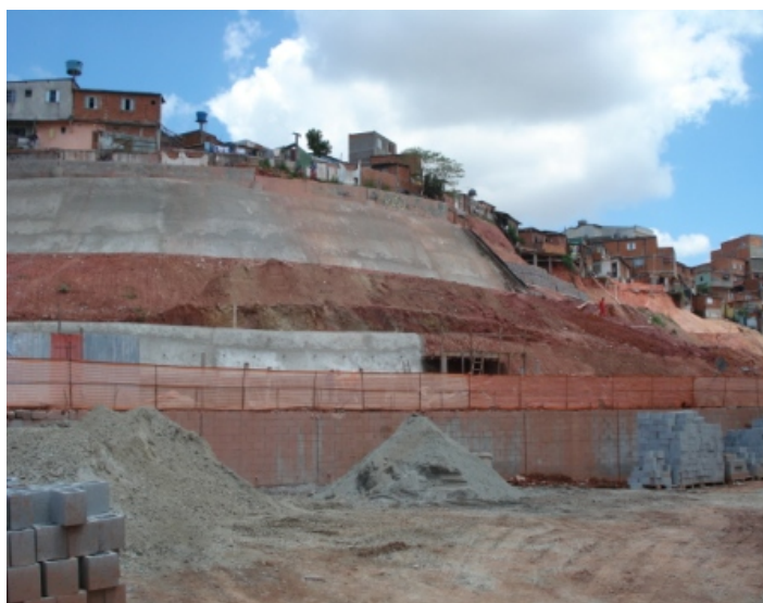
Figura 19. Imagem de uma obra de revestimento artificial para proteção de um talude. Fonte: IPT.
