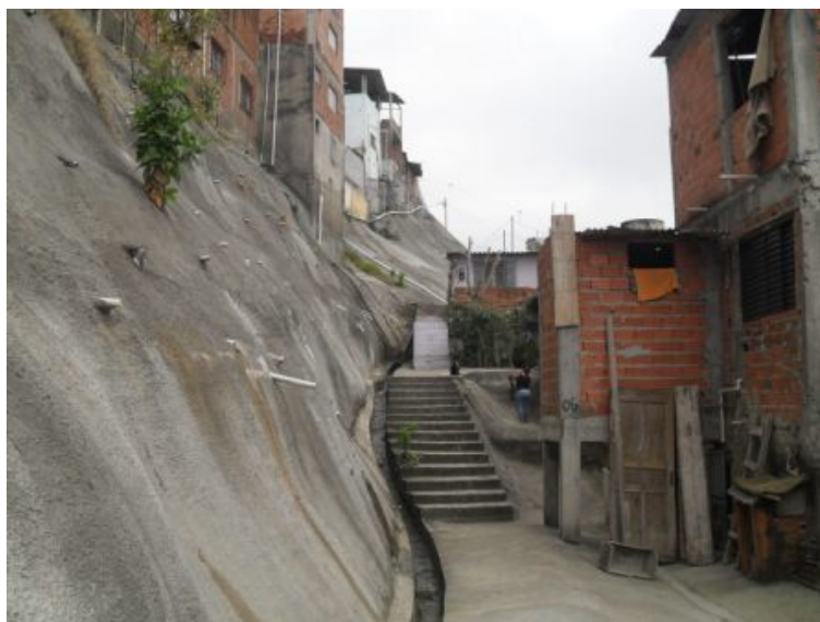
Figura 20. Imagem de uma obra de contenção e estabilidade de encosta complementadas com valetas de drenagem. Fonte: IPT.
