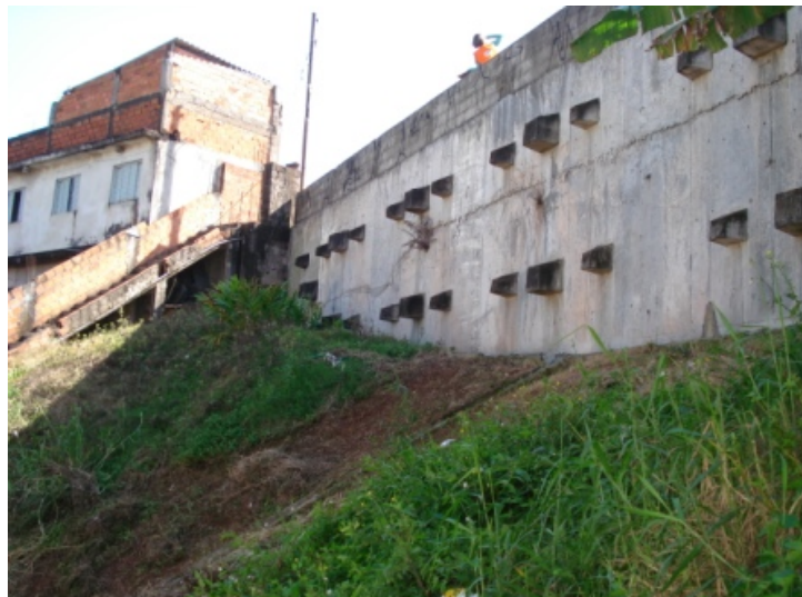
Figura 16. Imagem de obra realizada com uso de atiramentos. Fonte: IPT.
