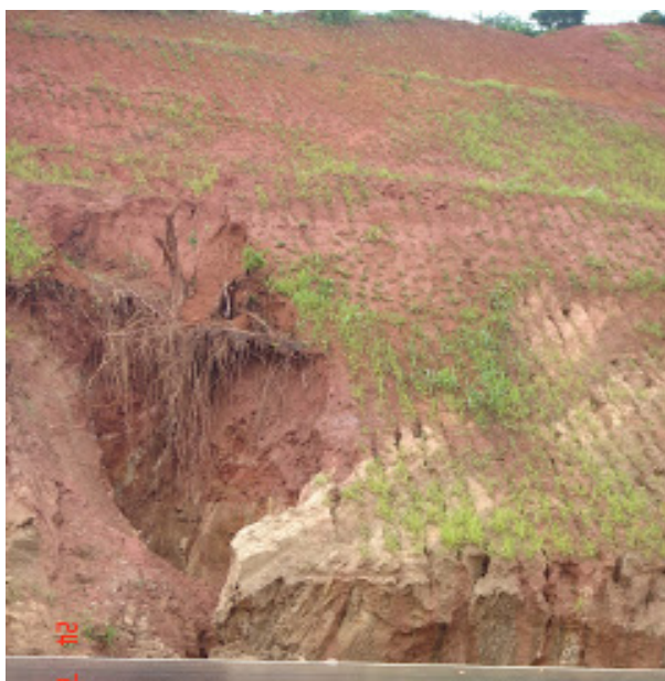
Figura 17. Imagem de erosão de talude, em margem de rio, ocasionada pelo escoamento superficial das águas de chuva.
