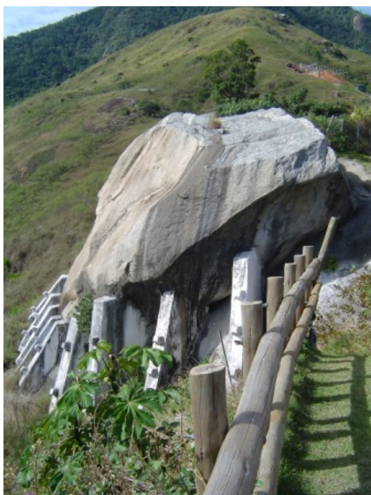
Figura 11. Imagem de uma obra de estabilização de um bloco de rocha. Fonte: IPT.
