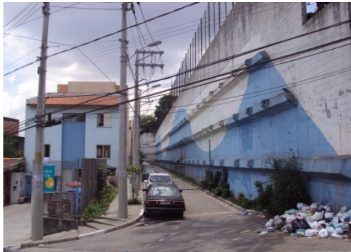
Figura 15. Imagem de obra realizada com uso de atiramentos. Fonte: IPT.
