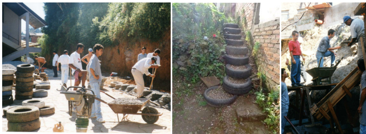
Figura 58. Imagens das aulas práticas mostrando a construção de “muro de pneus”, “escadaria no terreno de um morador” e “obra de contenção (gunitagem) para manter moradias em segurança”
