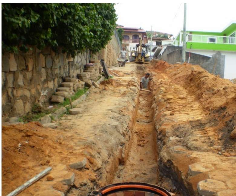
Figura 26. Imagem de uma construção de rede coletora de esgoto no maciço do Morro da Cruz, Florianópolis/SC.
