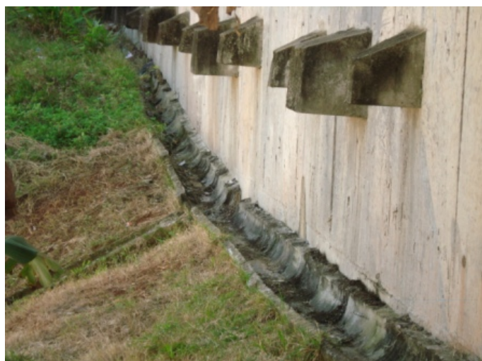
Figura 21. Imagem de uma obra de contenção e estabilidade de encosta com utilização de estruturas de drenagem. Fonte: IPT.
