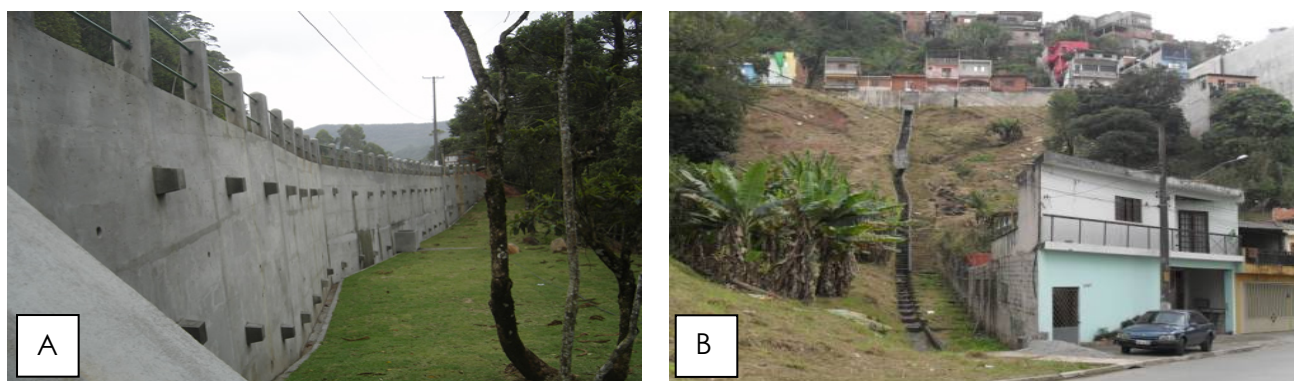
Figura 2. Medidas estruturais em encostas: (A) Cortinas atirantadas na Rodovia RJ 142, Nova Friburgo-RJ; (B) Escadaria hidráulica.
