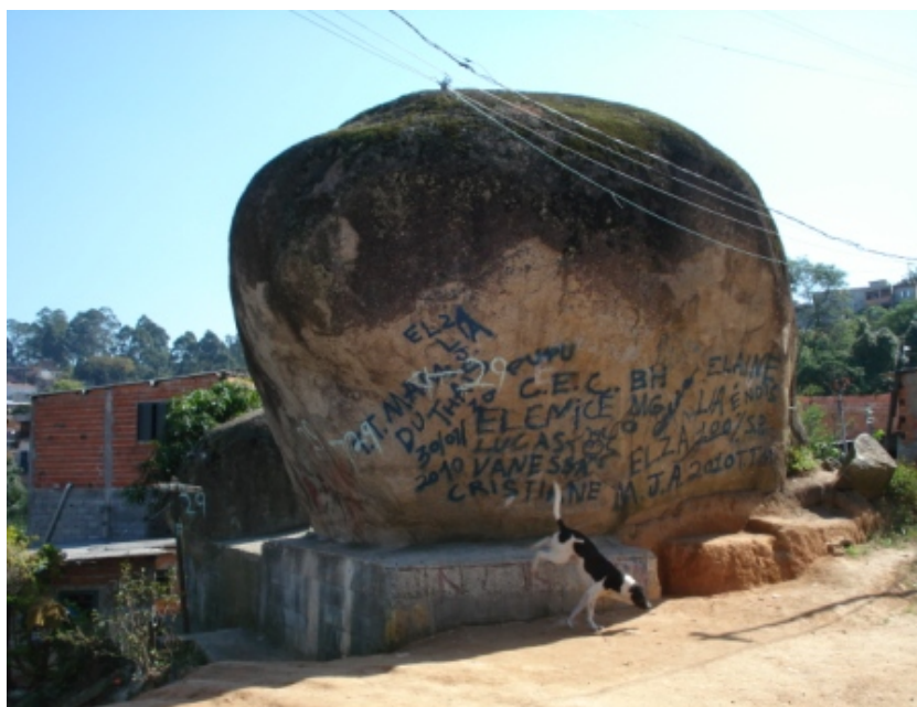
Figura 12. Imagem de uma obra de estabilização de um bloco de rocha. Fonte: IPT.
