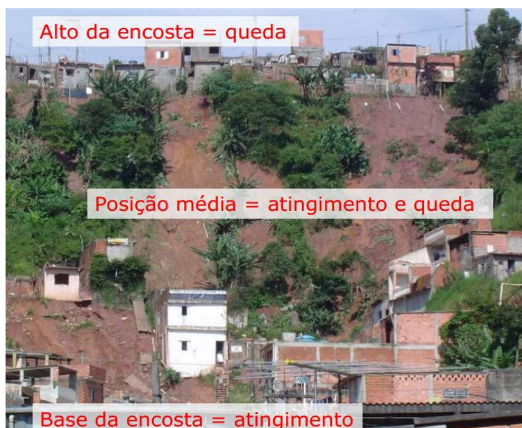
Figura 12. Exposição de habitações a deslizamentos em diferentes posições na encosta. Fonte: IPT (2012).
