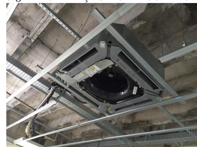
FOTO 5 – INSTALAÇÃO DO AR CONDICIONADO
