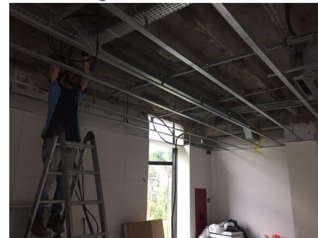
FOTO 5 – PASSAGEM DE CABOS
