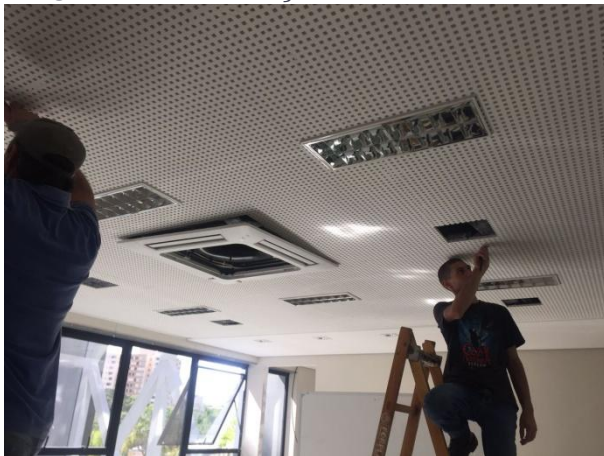
FOTO 3 – INSTALAÇÃO DE LUMINÁRIAS
