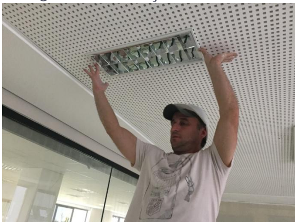
FOTO 3 – INSTALAÇÃO DE LUMINÁRIA
