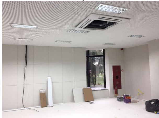
FOTO 3 – INSTALAÇÃO DE LUMINÁRIAS
