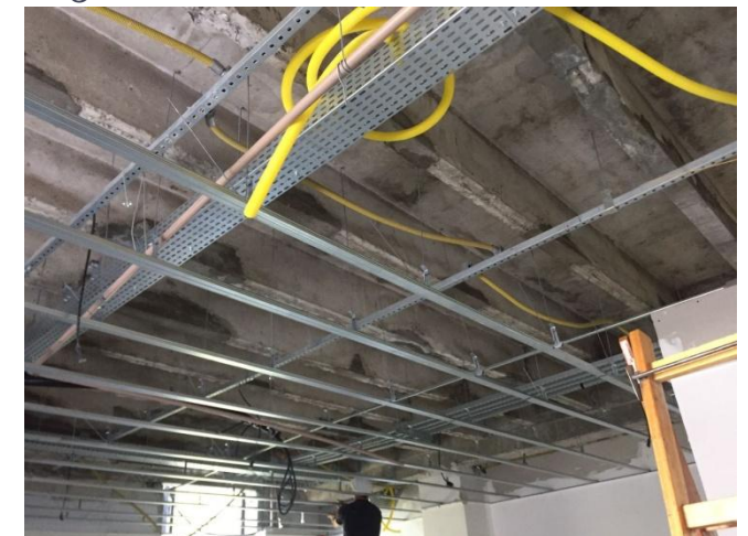
FOTO 5 – ELETROCALHAS E ELETRODUTOS
