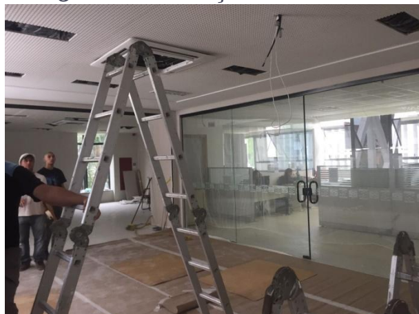
FOTO 3 – INSTALAÇÃO DE LUMINÁRIAS
