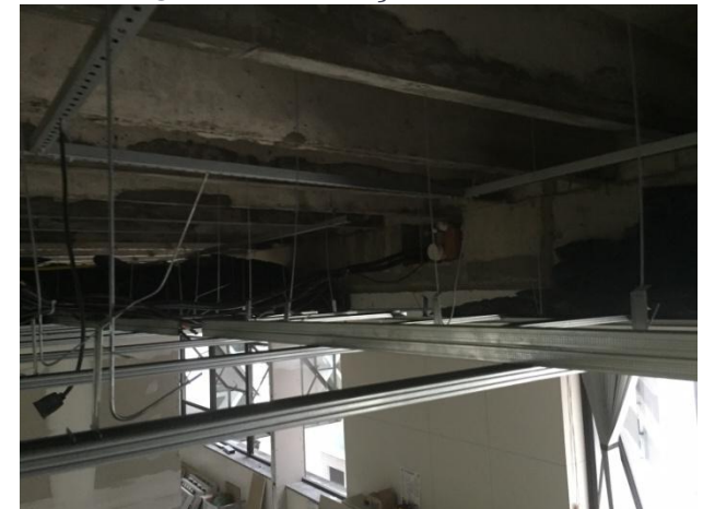
FOTO 5 – INSTALAÇÃO DO FORRO
