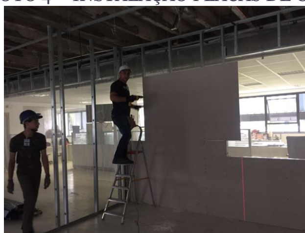
FOTO 4 – INSTALAÇÃO PLACAS DE GESSO
