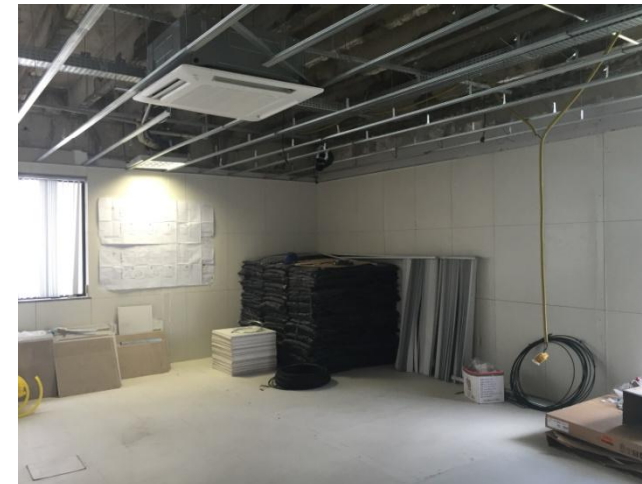
FOTO 5 – INSTALAÇÃO DO AR CONDICIONADO
