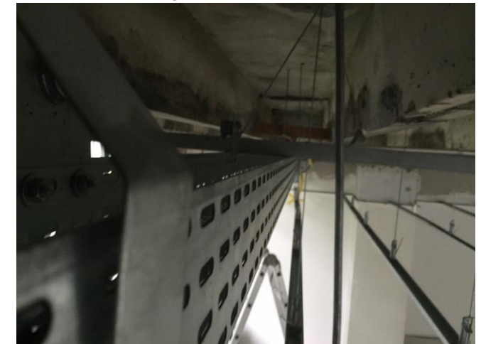
FOTO 5 – ELETROCALHA
