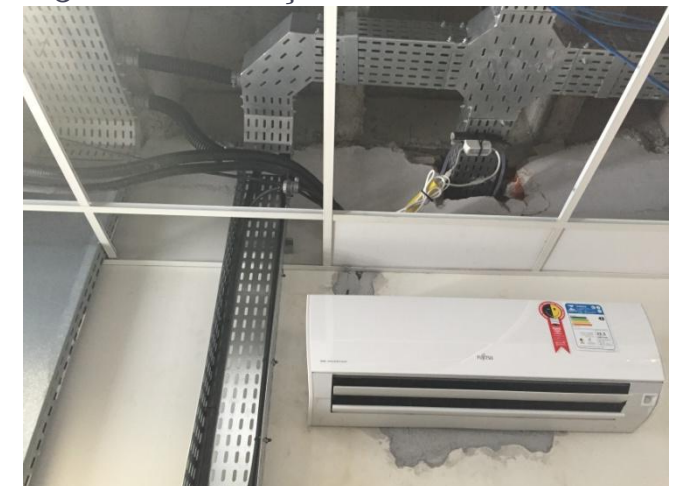
FOTO 5 – INSTALAÇÃO DO AR CONDICIONADO
